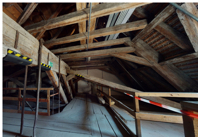
Dachwerke ©SKB / Wolfgang MoMo Handl
